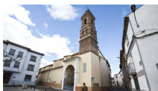
1-INM-ZAR-016-150-001-1_1 Torre de la Iglesia de San Francisco de Asís Lumpiaque (Zaragoza)
