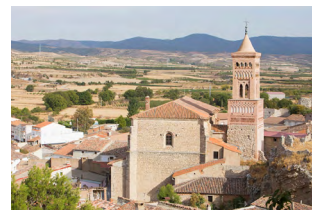
7-INM-ZAR-020-046-001 Ábside y torre de la Iglesia de San Miguel Belmonte de Gracián (Zaragoza)
