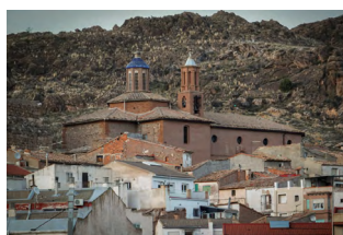
1-INM-ZAR-014-126-001 Iglesia de San Juan Bautista Illueca (Zaragoza)
