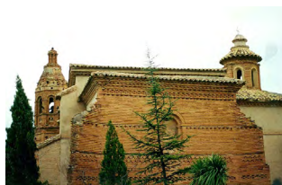
1-INM-ZAR-020-241-002 Torre e Iglesia de San Miguel Sabiñán (Zaragoza)
