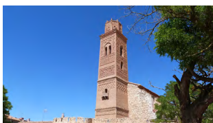
7-INM-ZAR-024-227-001-7_1 Torre de la Iglesia de San Pedro Apóstol Romanos (Zaragoza)
