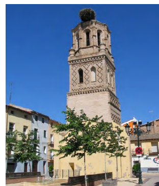
1-INM-ZAR-017-297-355 Torre de la Iglesia de San Miguel Monzalbarba (Zaragoza)
