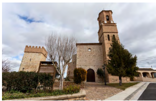
1-INM-ZAR-024-292-001-1_1 Torre de la Iglesia de San Miguel Arcángel Villarreal de Huerva (Zaragoza)
