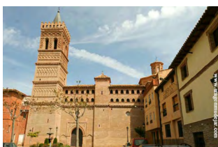
7-INM-ZAR-024-124-001 Torre e Iglesia de San Juan Bautista Herrera de los Navarros (Zaragoza)
