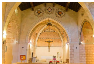
1-INM-ZAR-019-092-001-1_1 Techumbre de la Iglesia de San Juan Bautista Chiprana (Zaragoza)
