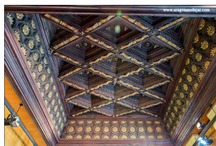
1-INM-ZAR-017-297-169-1_1 Techumbres en el Ayuntamiento de Zaragoza Zaragoza (Zaragoza)
