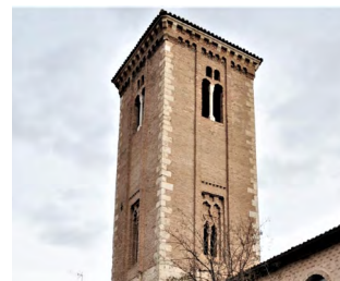
7-INM-ZAR-024-094-003-7_1 Torre de la Iglesia de Santo Domingo de Silos Daroca (Zaragoza)
