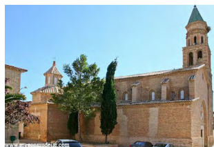
1-INM-ZAR-017-164-001-1_1 Iglesia de Santa Ana Mediana de Aragón (Zaragoza)
