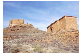
1-INM-ZAR-015-209-001-1_1 Ermita de Nuestra Señora de la Torre Pozuel de Ariza (Zaragoza)
