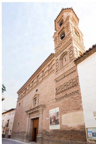
1-INM-ZAR-020-241-001 Iglesia de San Pedro Apóstol Sabiñán (Zaragoza)
