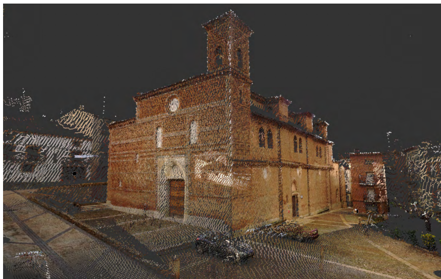
[Fig. 4.11] Nube de puntos de alta densidad obtenida mediante levantamiento fotogramétrico y escaneado láser de la Iglesia de Santa María de Tobed (Zaragoza). Elaborado por el Área de Expresión Gráfica Arquitectónica de la Universidad de Zaragoza
