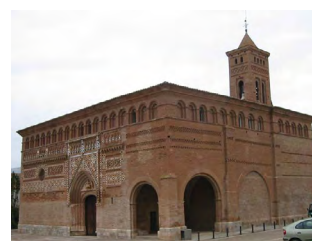
7-INM-ZAR-020-176-001 Iglesia de San Martín de Tours Morata de Jiloca (Zaragoza)
