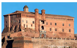
7-INM-ZAR-014-126-001 Palacio de los Luna. Techumbre y yeserías Illueca (Zaragoza)
