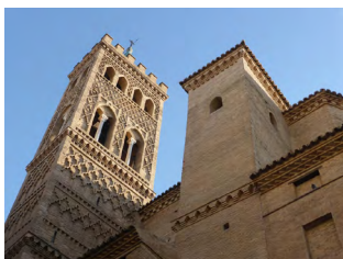
7-INM-ZAR-017-297-033 Iglesia de San Gil Abad Zaragoza (Zaragoza)
