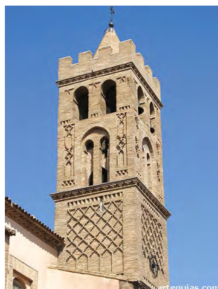
7-INM-ZAR-017-219-001-7_1 Torre de la Iglesia de la Asunción de Nuestra Señora La Puebla de Alfindén (Zaragoza)
