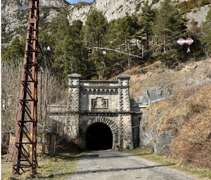
ILUSTRACIÓN 7. TÚNEL DE SOMPORT POR FERROCARRIL. FUENTE: AUTORA, 2022
