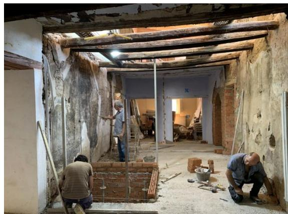
*Fig. 11. Hueco del ascensor segunda planta*
