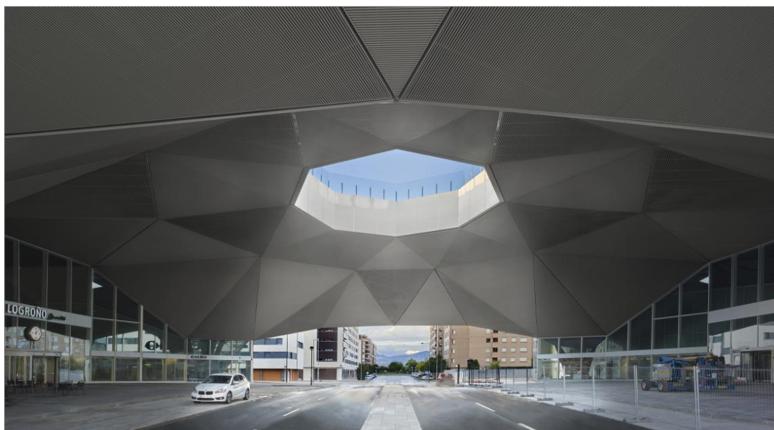
Figura 26: Unión de la estación de tren y de autobuses.
