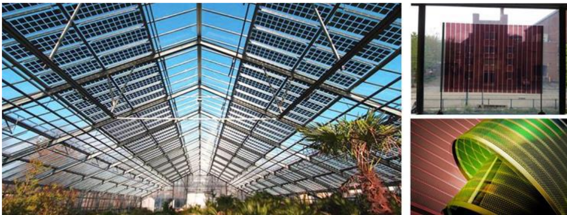
Figura 2. Ejemplo de invernadero con fotovoltaica rígida integrada en cubierta (izquierda), e imágenes de dispositivos OPV con semitransparencia fabricados sobre diferentes sustratos (derecha) [21].
