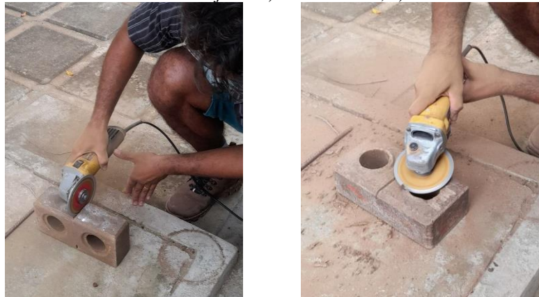
Figura 23 - Processo de corte dos tijolos. a) corte ao meio, b) retirada das reentrâncias.
