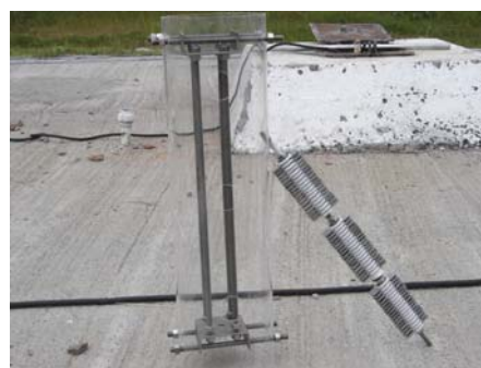
Foto 3. Proceso de instalación del rack portacupones en el pozo de agua.
