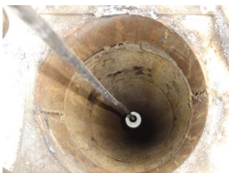
Foto 1. Proceso de instalación de los sensores electroquímicos en el pozo de agua.
