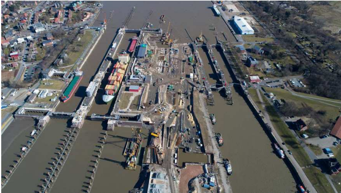
Bild 1: Baustelle der 5. Schleusenammer auf der Schleuseninsel (Jahr 2018)
