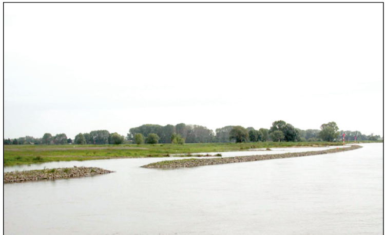
Abb.9: Ökologischer Umbau von Flussbauwerken - ein Leitwerk mit Durchströmungsöffnungen statt Buhnengruppe bei Gallin (siehe Beitrag A. Anlauf in diesem Band) (Foto: Guido Puhlmann).
