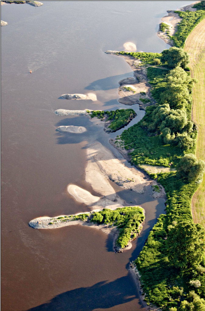
Abb. 14: Anlage einer Flutrinne hinter einer Bühnenwurzel, Apollensdorf, Elbe-km 221,9 – rechte Elbseite (Fotos: WSA Dresden, Andreas Hilger).
