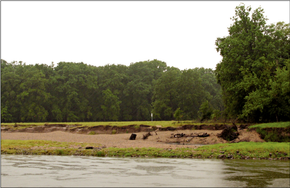
Abb. 11: Initiierte Uferabbrüche hinter einem Leitwerk, Matzwerder bei El-km 250 linke Elbseite (Foto: Petra Faulhaber).
