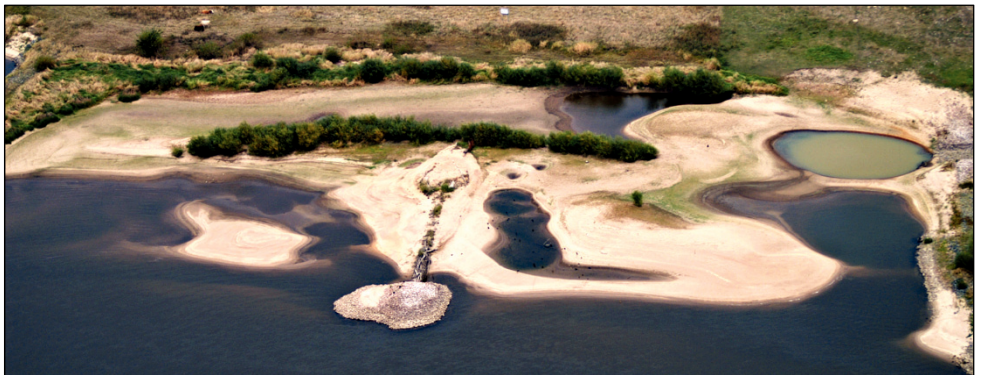
Abb. 18: Bau einer ökologischen Buhne als sogenannte „Totholzbugne“ bei Beuster, rechtes Ufer (Foto: Hubert Finke, 2009).
