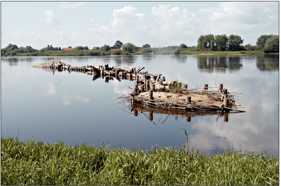
Abb. 17: Bau einer ökologischen Buhne als sogenannte „Totholzbugne“ bei Beuster, El-km 450,7 -linke Elbseite (Foto: Hubert Finke, WSA Magdeburg).
