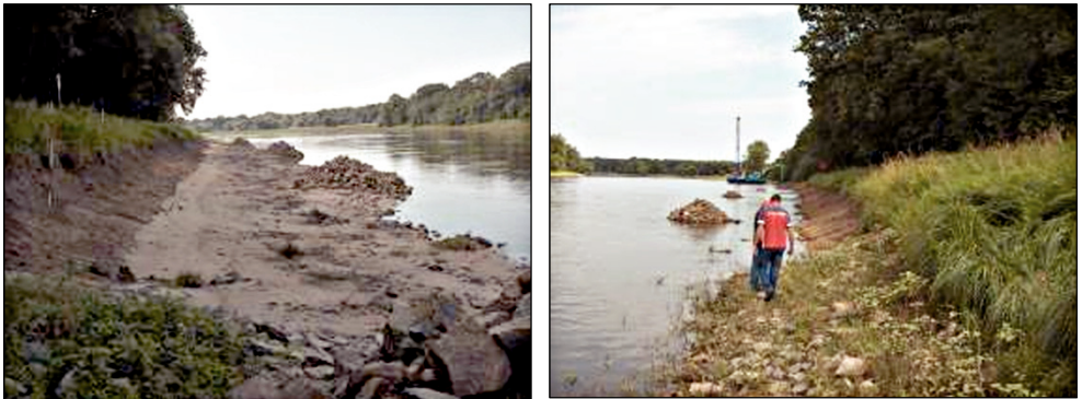
Abb. 15/16: Erster Rückbau eines Deckwerkes bei Steckby (Fotos: Andreas Regner).
