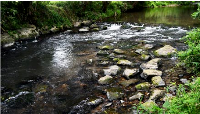
Abbildung 2: Naturnahe unstrukturierte Sohlengleite in der Ilme bei Einbeck (Niedersachsen, Deutschland; Aufnahme: Eikenberg)
