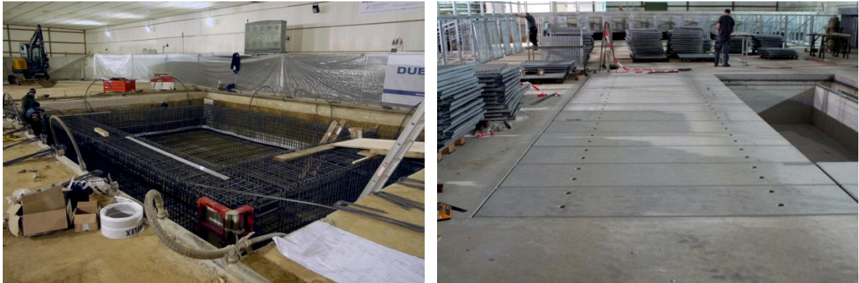
Abb. 3.8: links: Ausbildung der Bewehrung der Beckenwände im Tiefteil, rechts: fertiggestellter Tiefteil mit teilweise verlegten StB-Platten.
