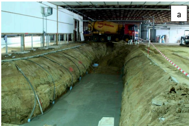
Abb. 3.5: a) Baugrube für den Rückführungskanal mit betonierter Sauberkeitsschicht und Grundwasserabsenkung; b) Detailausbildung der Bewehrung im Umlenkbereich des Rückführungskanals und Übergang.
