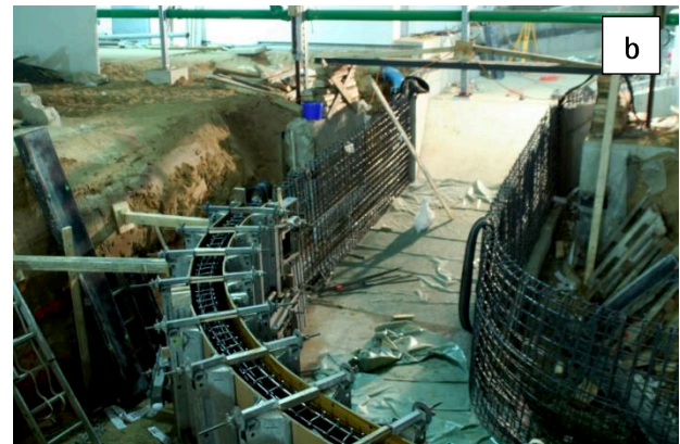
Abb. 3.5: a) Baugrube für den Rückführungskanal mit betonierter Sauberkeitsschicht und Grundwasserabsenkung; b) Detailausbildung der Bewehrung im Umlenkbereich des Rückführungskanals und Übergang.
