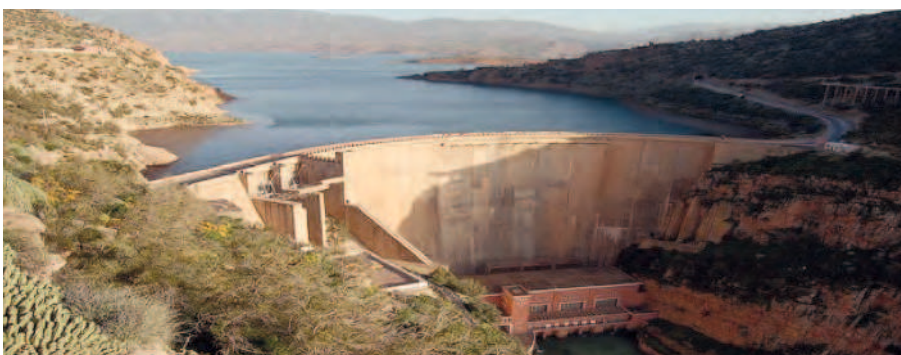
Bin El Ouidane dam
