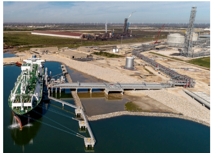
Figure 2 | Example LNG loading system.
