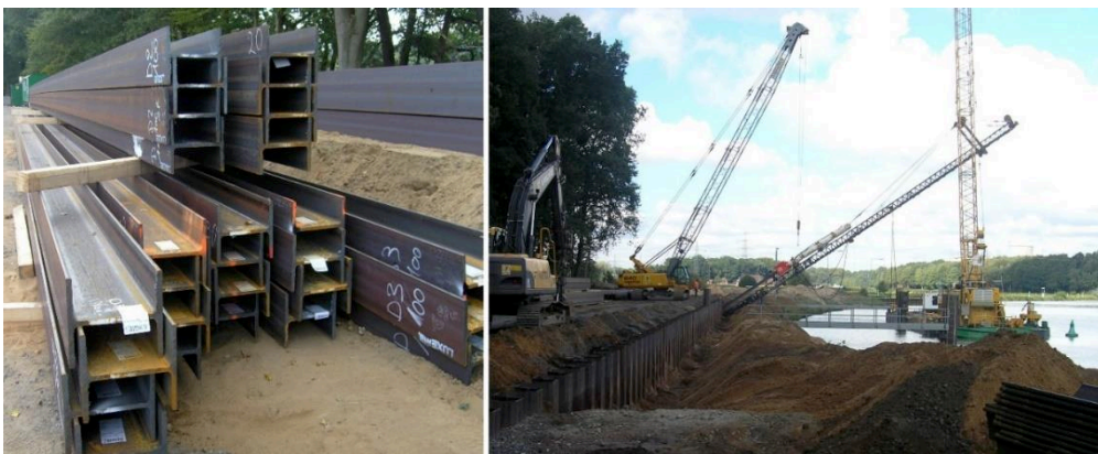
Abb. 7: Ramppfähle - Profile und Einbringung mittels schlagender Rammung (Quelle: BAW)
