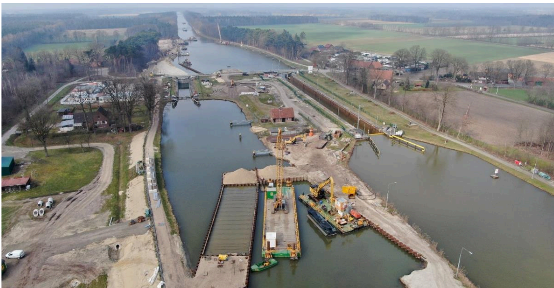
Abb. 5: Baustelle Venhaus im März 2021 (Quelle: WNA Datteln)
