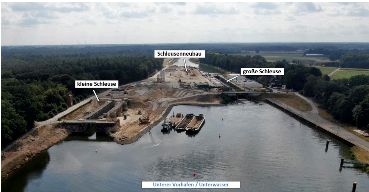
Abb. 2: Luftbild der Schleusenanlage Gleesen im August 2019 (Quelle: WNA Datteln)
