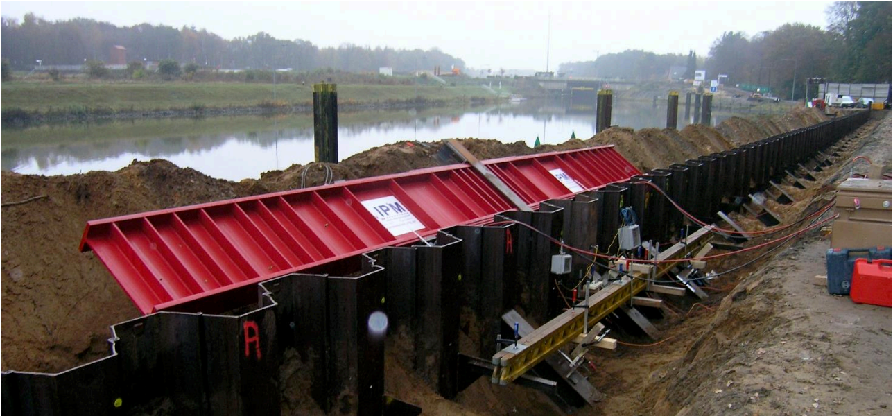
Abb. 9: Zugversuche an Rammpfählen - Aufbau der Prüfeinrichtung (Quelle: BAW)
