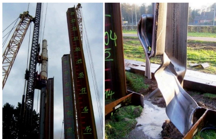
Abb. 6: Proberammung mit Hydraulikrammbär und deformiertes Spundwandprofil nach der Rammung (Quelle: WNA Datteln)
