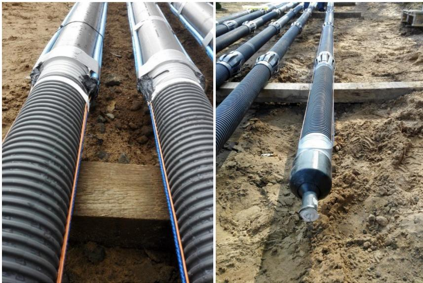
Abbildung 3: Angebrachte Glasfaserkabel vor dem Einbau des Einstabankers im Übergangsbereich zwischen Ripprrohr und Glattring (links) und im Fußbereich (rechts)
