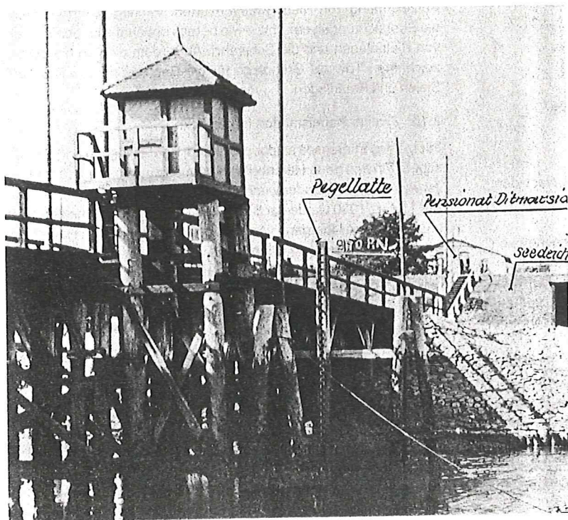
Abb. 6.5: Pegelanlage am Standort Inselbrücke *)
