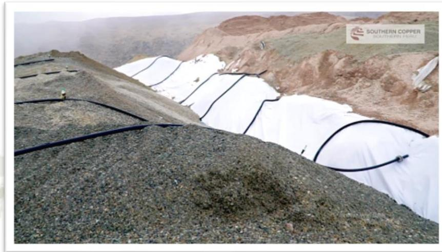
*Nota.* Pilas de lixiviación con geomembrana blanca, Esta geomembrana tiene mejor resistencia a exposición a la intemperie. Tomado de Southern Copper (2018).
