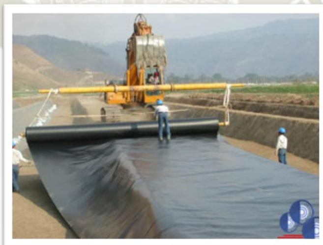
*Nota.* Excavadora de oruga con elementos adaptados para desenvolver la geomembrana. Tomado de Omali (2020).
