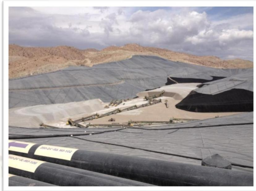
*Nota.* PAD 4B de Sociedad minera cerro verde. La figura se aprecia la colocación de geomembrana para posteriormente disponer el mineral. Tomado de (Sociedad minera cerro verde, 2017).
