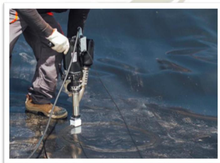
*Nota.* En la imagen se ve un operador realizando soldadura por extrusión en geomembrana, Tomado de Aristegui maquinaria (2021).
