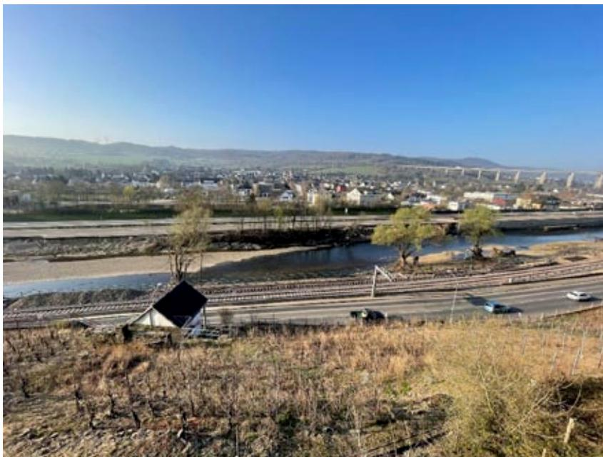
**Abbildung 3:** Engstelle der Ahr bei Heimersheim. Eisenbahnstrecke und vierspurige Schnellstraße wurden an beiden Ufern der Ahr zerstört; die Ahr zeigte Schotterablagerungen im Flussbett die zu einer Aufhöhung der Ahr führten und zukünftige Hochwasser verstärken können. (Foto: F. Lehmkuhl, 2022)
