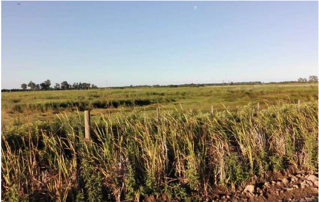
Figura N°34. Vegetación en el Drenaje en Araña.
