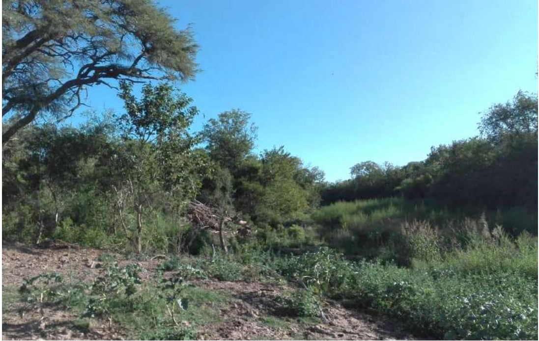
Figura N°33. Canal frente al puente de la circunvalación, al sur de ENS N°26.
