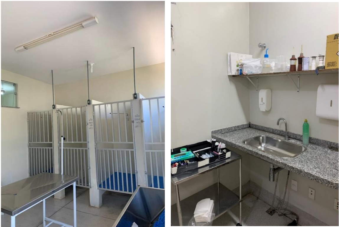
Figura 11. Sala de internação de pacientes com doenças infecto-contagiosas da CVU – Clínica Veterinária Universitária UFT EMVZ com capacidade para 4 animais.
