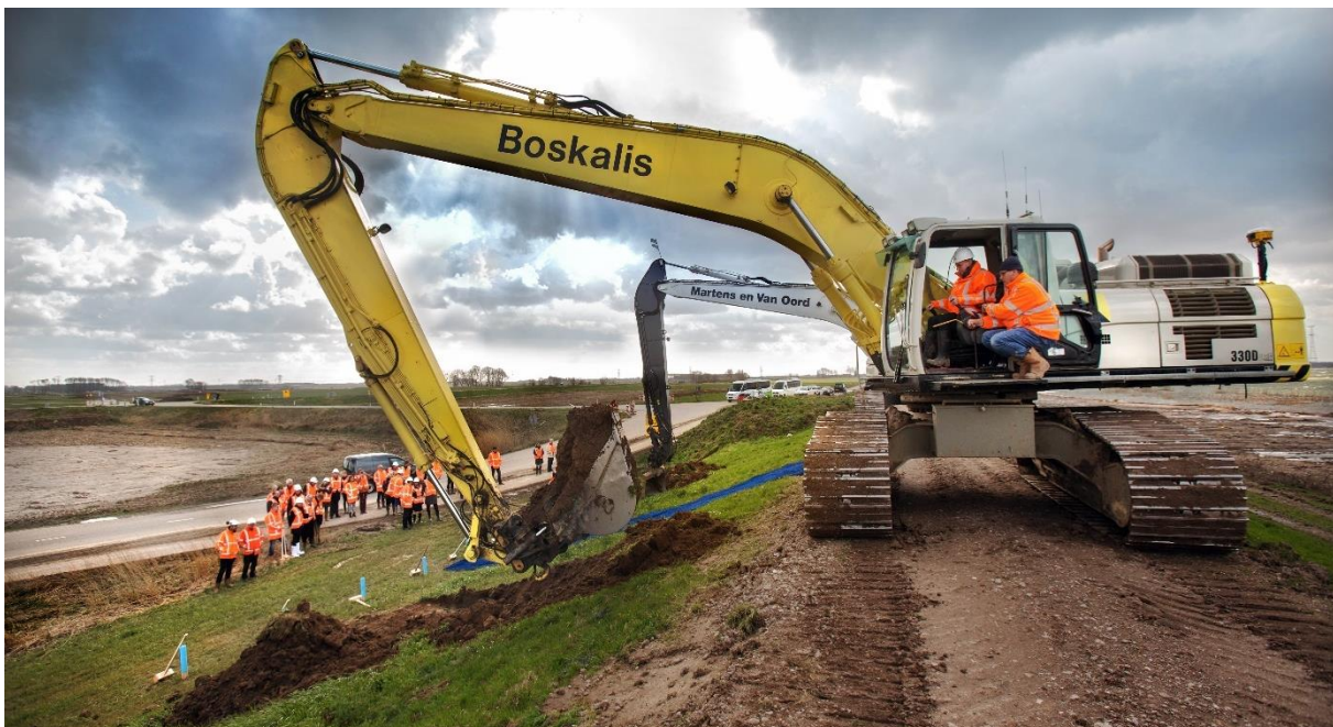
Figuur 11. Werkzaamheden in de Noordwaard (bron: beeldbank.rws.nl, Rijkswaterstaat, Ruimte voor de Rivier / Werry Crone)
