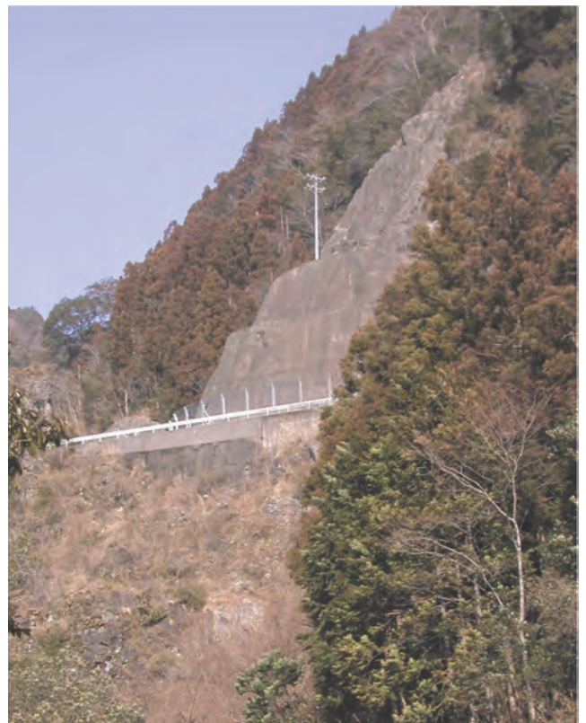
図10. 「木頭石」採掘跡。那賀町(旧木沢村)大美谷口より撮影。
