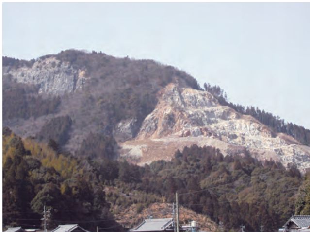
図 11. 「時鳥」採掘跡、阿瀬比国道南よりの遠景。尾根左上部の古い採掘跡より採掘された。
