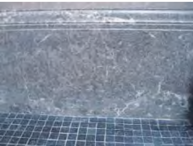
図 11 「淡雪」中のサンゴを含む黒色石灰岩塊. 天皇御休所前の幅木.
