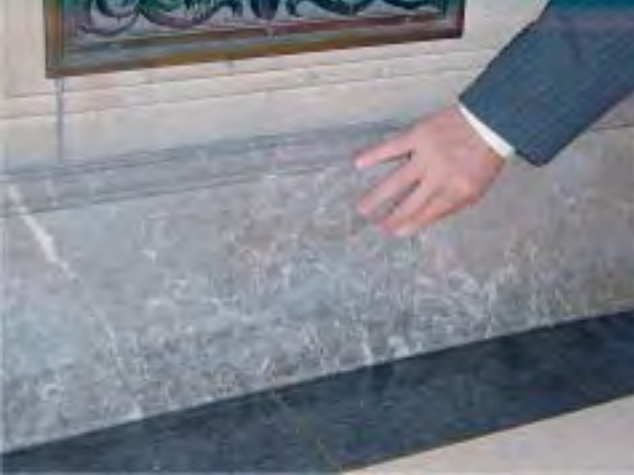
図 8a 2 階中庭まわり廊下の幅木に使われている「新淡雪」と、その前に置いた阿南市宝田町井関産大理石.
