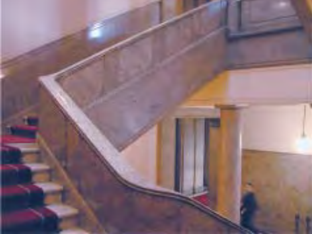
図 2a 第二議員階段手すりと壁の「曙」. 参議院第二議員階段 2～3 階.
