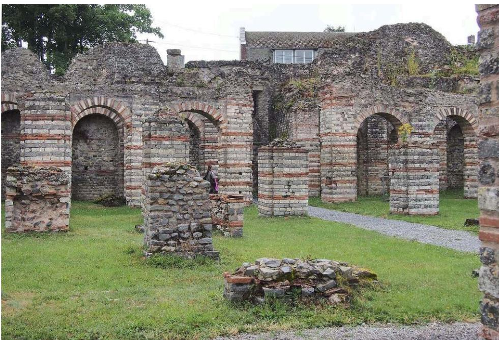
Les moellons sont en matériaux divers : grès, pierre bleue (calcaire givétien), calcaires lutétiens (à milioles et à *Ditrupa*) et calcaires jurassiques de la Meuse alternant avec des rangs de briques.
