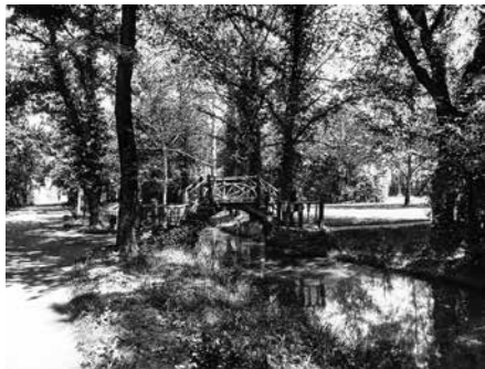
Fig. 56 Il ponte di Pietra e Legno (detto "ponte Svizzero") (1824) sul Canale Navigabile delle Pavoniere (già fosso Chiaro delle Pavoniere); è il terzo ponte partendo dall'ingresso nord e risulta rialzato per consentire il passaggio delle imbarcazioni. Oggi permangono solo le spallette in pietra sugli argini del corso d'acqua, recentemente restaurate. Sulla sinistra, vi è lo Stradone delle Pavoniere (attuale Viale dei Lecci) e, sullo sfondo, l'ingresso nord dello stesso spazio recintato. Foto storica, 1890 ca., FAF, Firenze.
