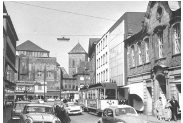
234 Ein Zug der Linie 2 in der Grossen Strasse, kurz vor dem Nicolaiort, im Gegenverkehr. (Foto A. Spühr, 3. 4. 1960)
