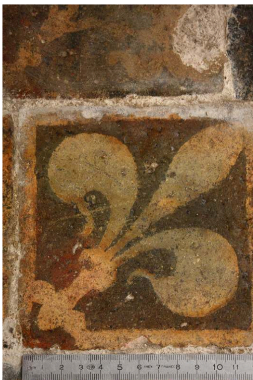
Fig. 9b. Cluny, carreaux bicolores à cuisson réductrice avec cercle gris de surface (071.52).
