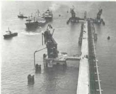
Wilhelmshaven: Die 705 m lange Tankerlöschbrücke ermöglicht es, die Ladung mehrerer Öltanker gleichzeitig zu löschen.
