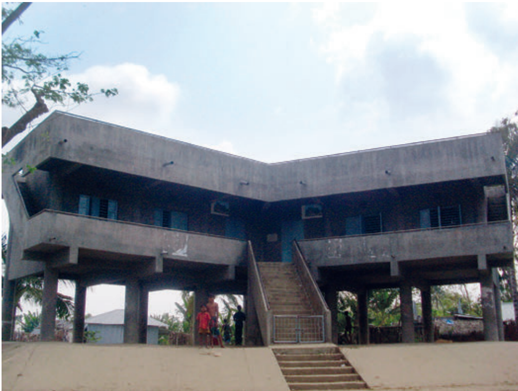
Abbildung 7.1: ‚Cyclone Shelter‘ am 09. April 2009, Southkhali Grundschule, Sharankhola Foto: B. Mallick, 2009
