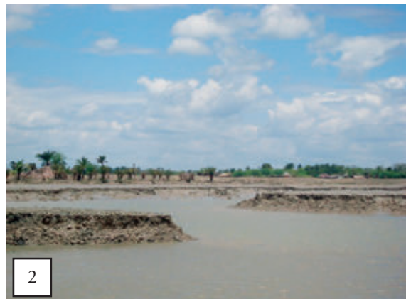
Abbildung 4.10: (1) Wiederaufbau eines Bambuszauns und Sandschüttung (2) Gebrochener Deich Foto: B.Mallick, 2010
