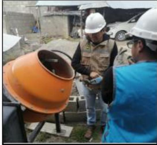
Imagen 26: preparación del concreto con una resistencia  $f_c$  210  $\text{kg/cm}^2$
