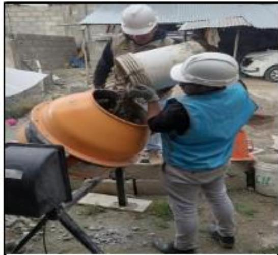
Imagen 28: llenado del agregado grueso en la preparación del concreto
