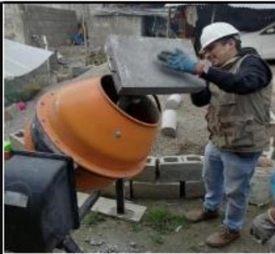
Imagen 27: llenado del cemento en la preparación del concreto cumpliendo el diseño de mezcla
