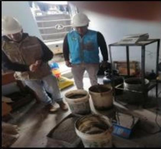
Imagen 25: material listo para la preparación del concreto con una resistencia  $f_c$  210  $\text{kg/cm}^2$
