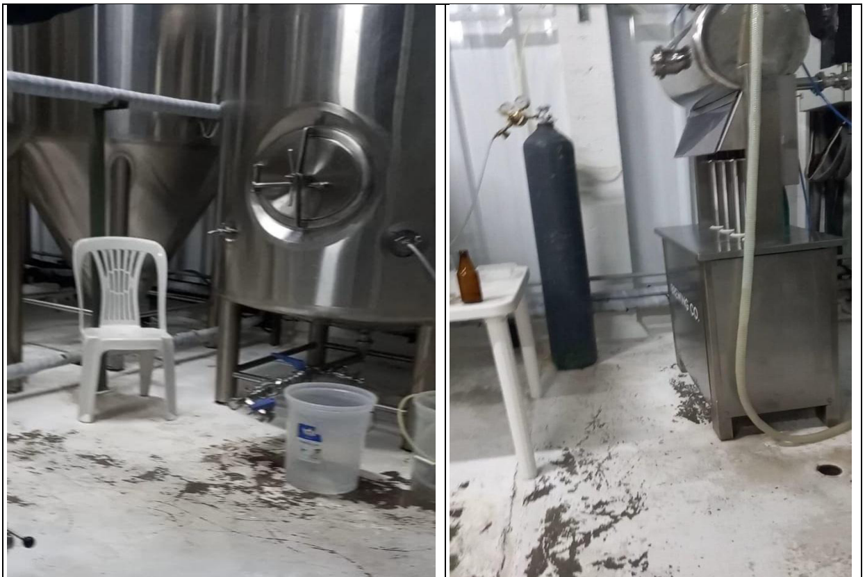
Figura 13. a) Tanque de carbonatación y b) Balón de CO 2
