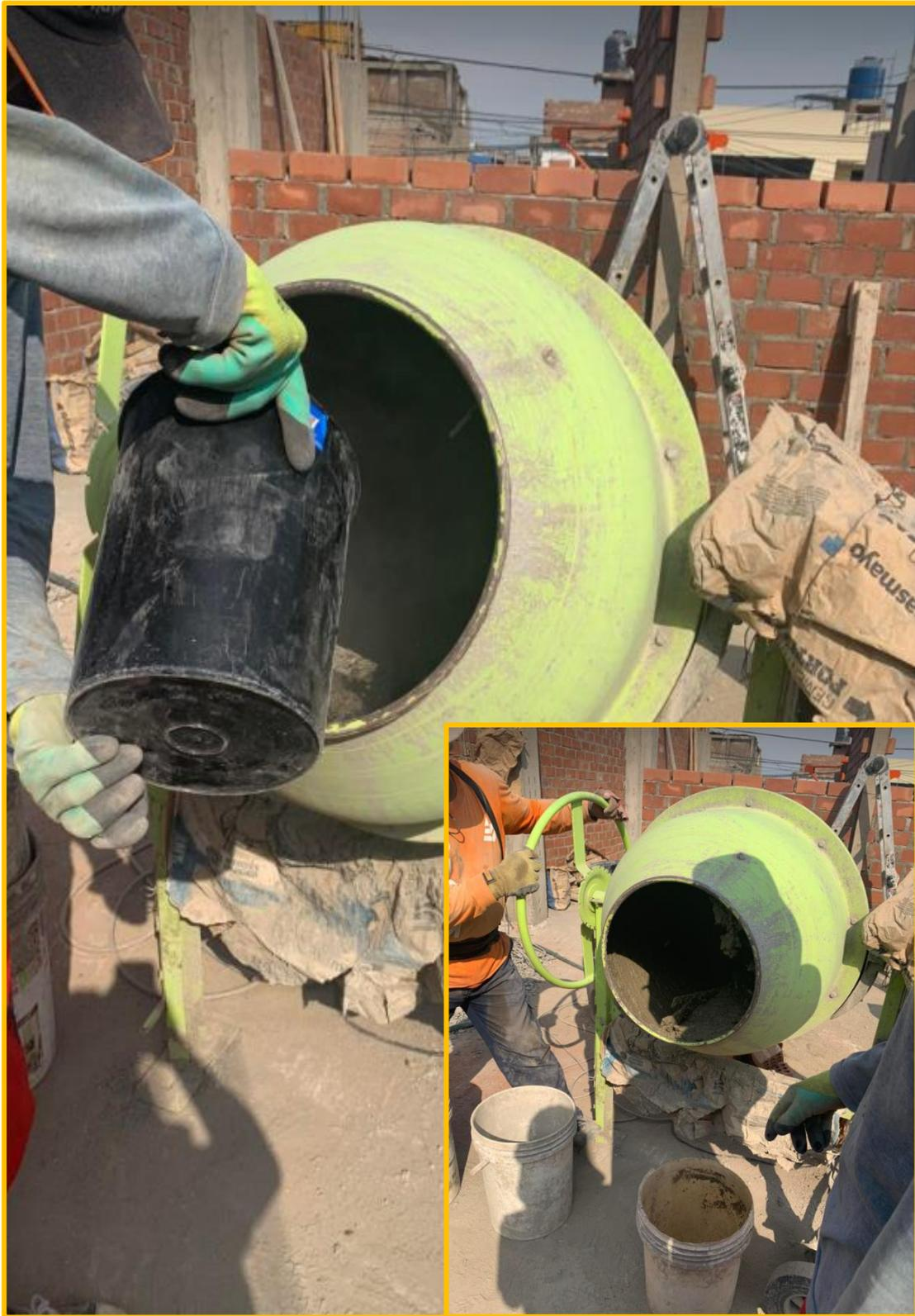
**COMENTARIO:** El primer día de la preparación de la muestra fue para un concreto patrón, por ende, se colocaron en la mezcladora de concreto únicamente materiales convencionales según el diseño de mezcla proporcionado por el laboratorio.
