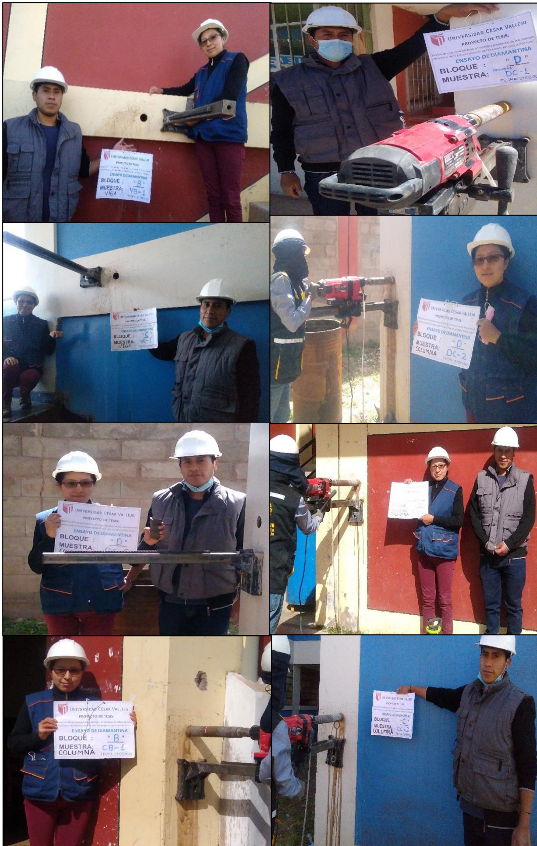
Figura 31. Extracción testigos de concreto ESFA (Ensayo de Diamantina).
