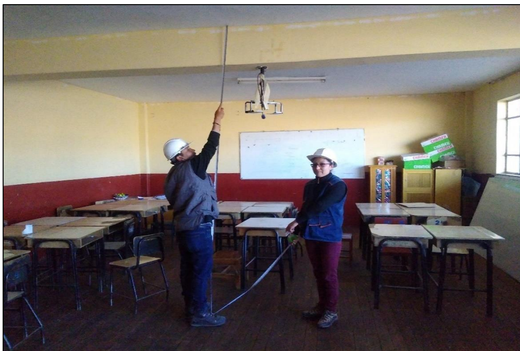
Fotografía realizando la medición de las vigas en aulas para comparar con los planos obtenidos.
