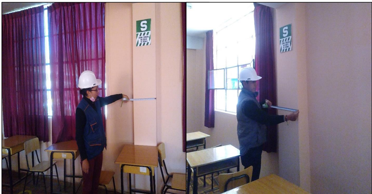
Fotografía realizando la medición de las columnas para contrarrestar con los planos obtenidos.
