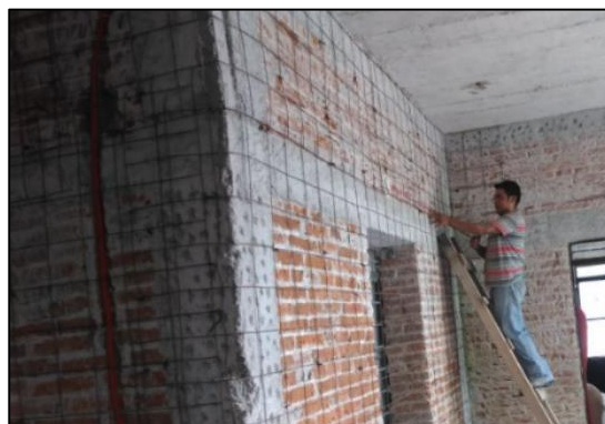
Figura 10. Refuerzo de muros con Malla Electrosoldada.
