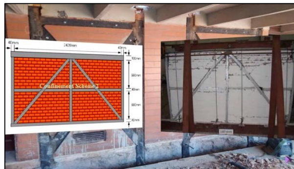
Figura 5. Marcos metálicos en interior de una edificación.
