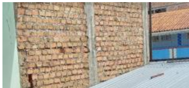
Figura 13. Ladrillo recio en las paredes
