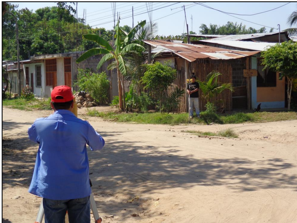
Foto N° 02.- Tesista realizando el levantamiento topográfico Jr. Oriental C-2
