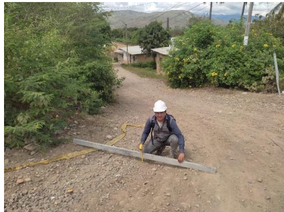
Fotografía N° 12: Muestra deterioro de erosión en el jirón Junín.
