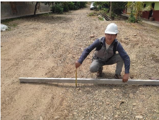
Fotografía N° 17 y 18: Muestra deterioro de deformación y erosión en el jirón Arica.
