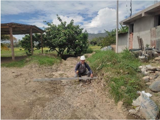
Fotografía N° 9: Muestra deterioro de erosión en el Jirón Atahualpa.
