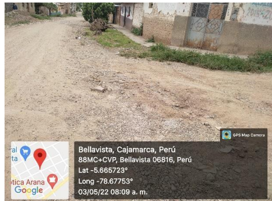
Fotografía N° 17 y 18: Muestra deterioro de deformación y erosión en el jirón Arica.
