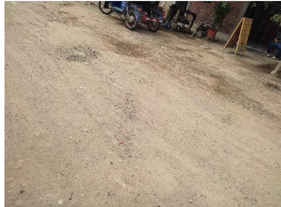
Fotografía N° 15 y 16: Muestra deterioro de erosión y Baches o huecos en el jirón Villanueva Pinillos.
