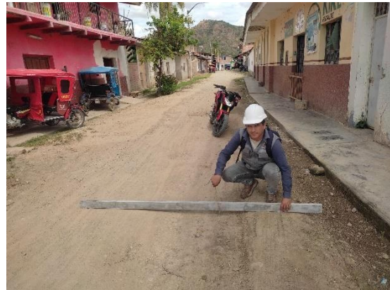
Fotografía N° 22: Muestra deterioro de deformación en el jirón José Olaya.
