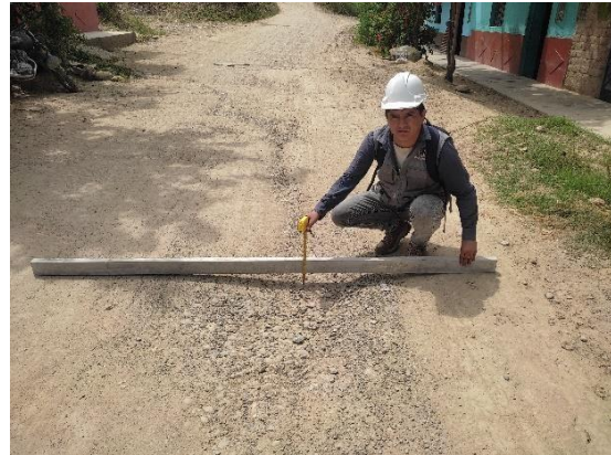
Fotografía N° 22: Muestra deterioro de deformación en el jirón José Olaya.
