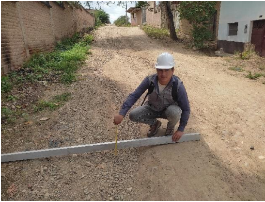
Fotografía N° 15 y 16: Muestra deterioro de erosión y Baches o huecos en el jirón Villanueva Pinillos.
