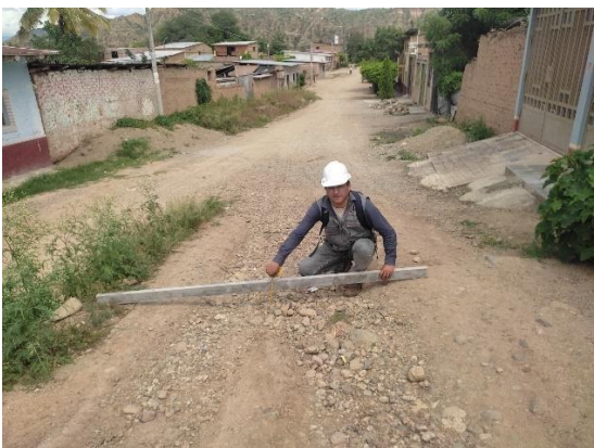
Fotografía N° 11: Muestra deterioro de erosión en el Pasaje Ayacucho.
