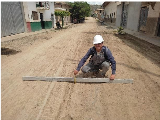
Fotografía N° 17 y 18: Muestra deterioro de deformación y erosión en el jirón Arica.
