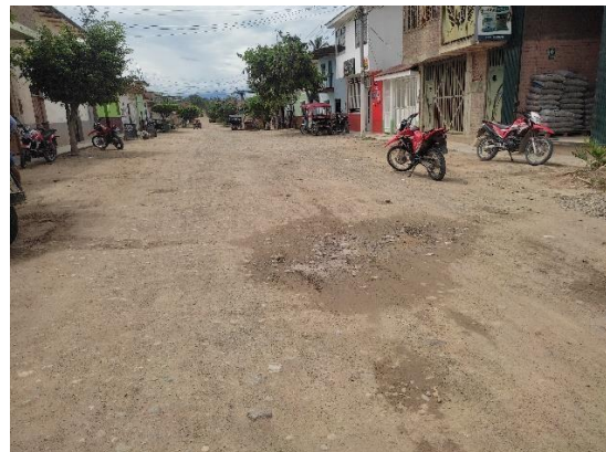
Fotografía N° 17 y 18: Muestra deterioro de deformación y erosión en el jirón Arica.
