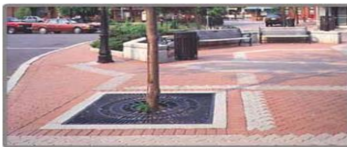
Figura 1: Pavimento de adoquín peatonal.
