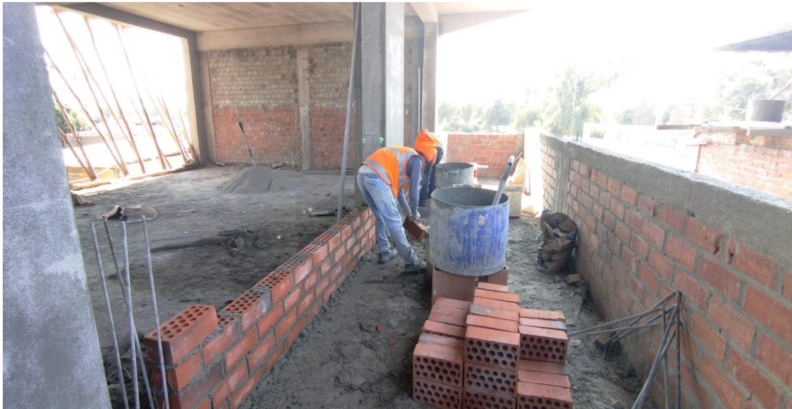
Figura n°01: construcción de muros de tabiquería con unidades de albañilería (Ladrillo King Kong 18 huecos)
