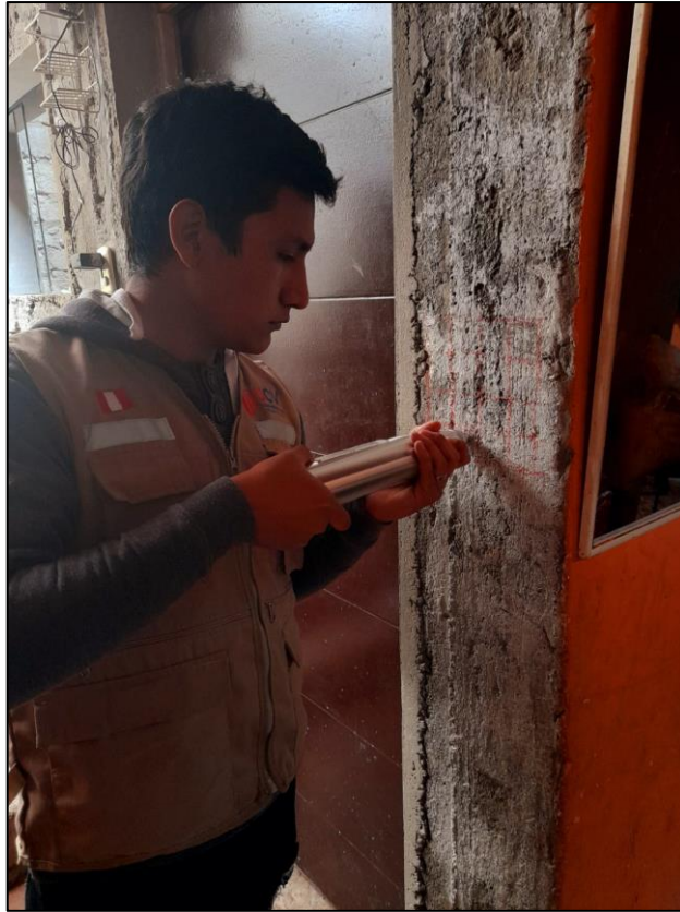
Foto 33. Realizando ensayo de esclerometría en columna de vivienda 03.
