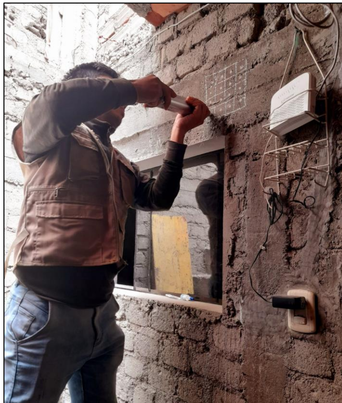
Foto 34. Realizando ensayo de esclerometría en viga de vivienda 03.
