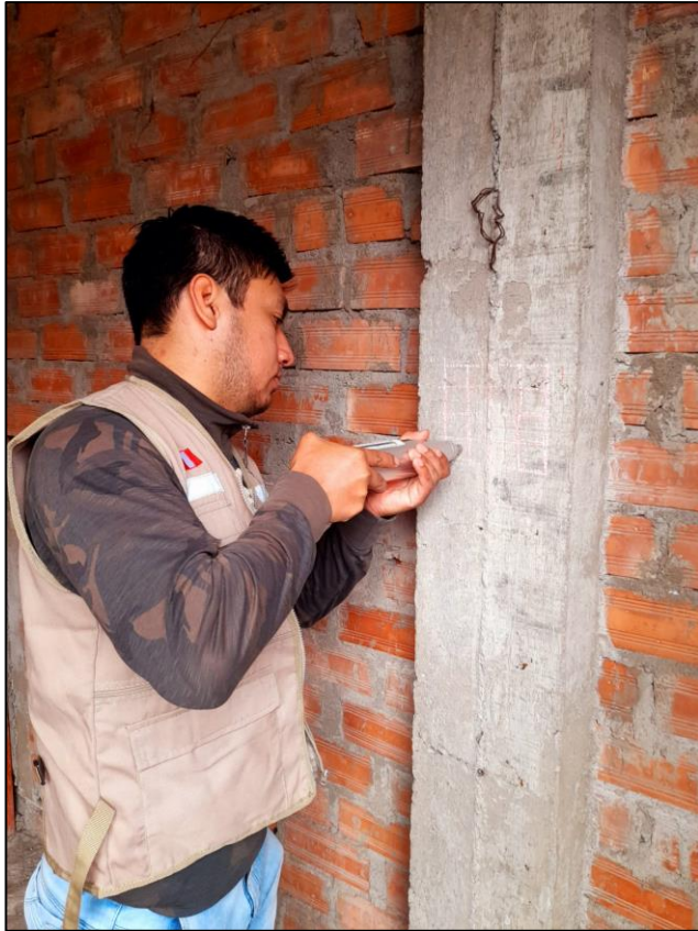
Foto 31. Realizando ensayo de esclerometría en columna de vivienda 02.
