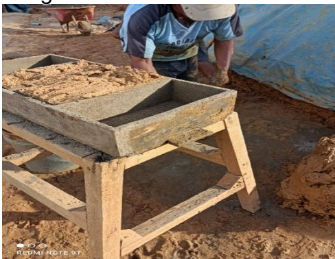
Figura 50. Se junta el adobe sobrante
