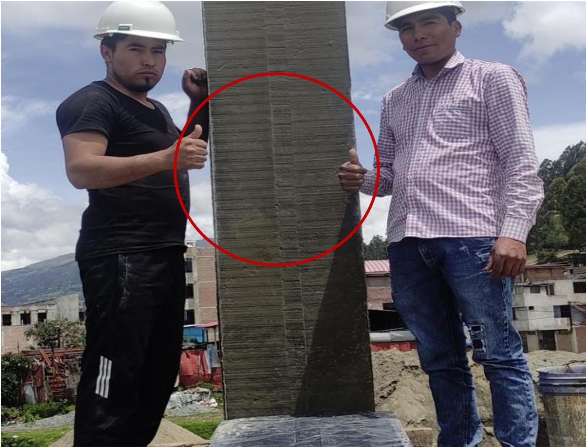
**Nota:** la fotografía de fuente propia nos muestra el carácter y aspecto físico arquitectónico de firmeza y versatilidad del acabado del concreto expuesto. (ubicación del pórtico, zona externa de la vivienda donde no se utilizará acabado, expuesto a la intemperie hasta su deterioro y demolición por desgaste), con burbujas y aire atrapado pero que no afectan en la resistencia del material.
