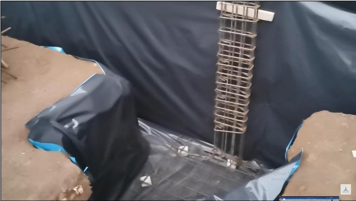
**Nota:** la figura nos muestra el proceso de colocación del plástico en un suelo perfilado con un operario y un peón en zapatas fuente propia.
