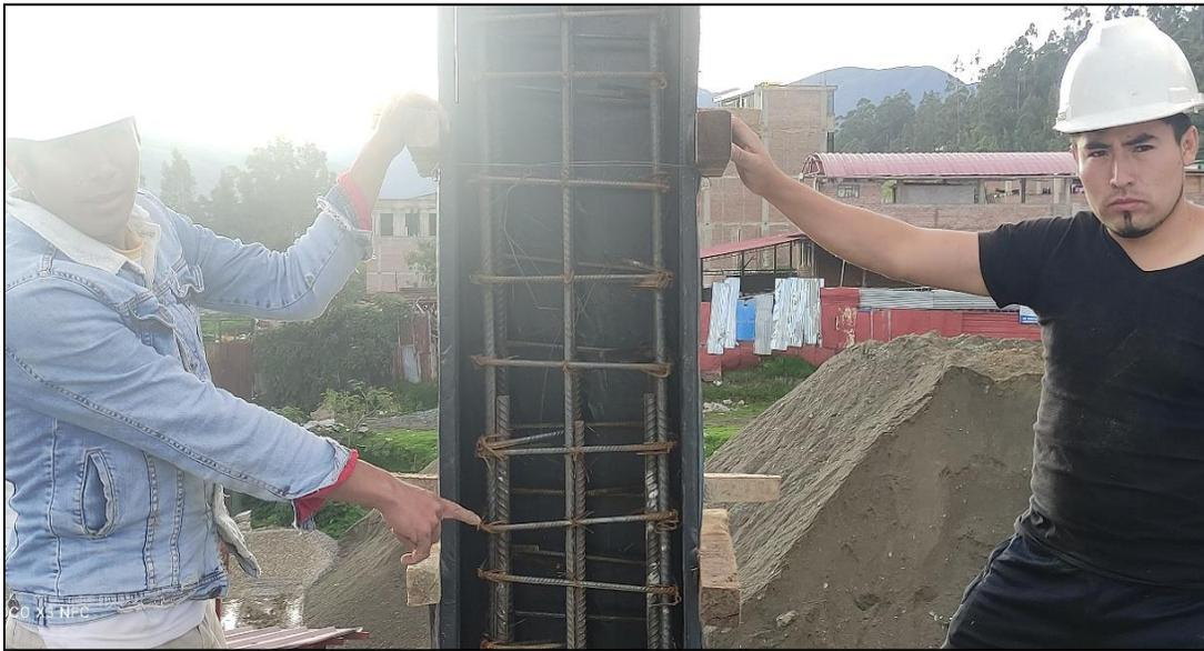
**Nota:** la figura de elaboración propia nos muestra el cuidado que debemos tener con dañar el plástico, luego de su culminación del encofrado se realizara el llenado del concreto  $f'c=210$ .
