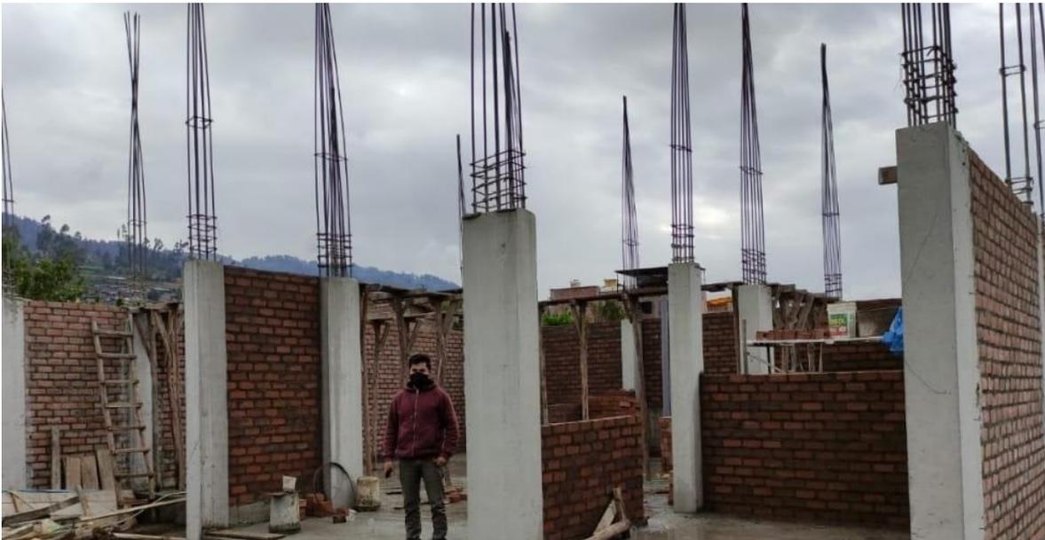
**Nota:** fotografía propia tomada después de los desencofrados entre los 30 días calendarios listo para hacer la prueba de resistencia con el esclerómetro.
