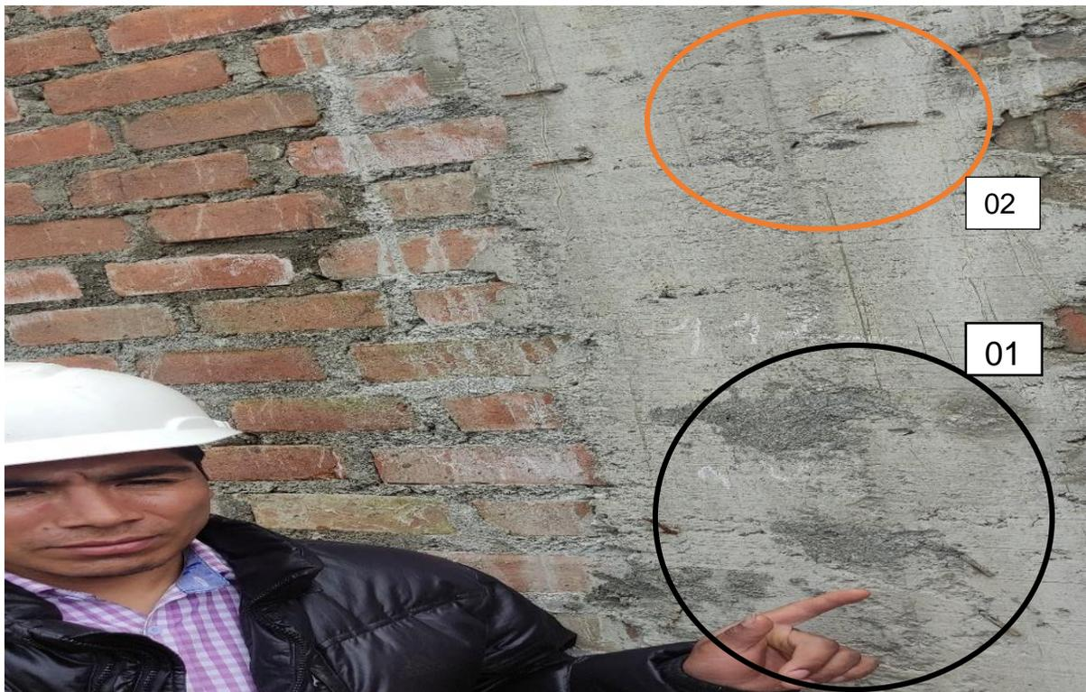
**Nota:** en la fotografía de fuente propia muestra las imperfecciones, en la piel del concreto o textura de aspecto falta de firmeza y vacíos irregulares en la superficie de concreto, variación de color debido a deficiencias en la mezcla o manifestaciones en forma de mancha etc.
