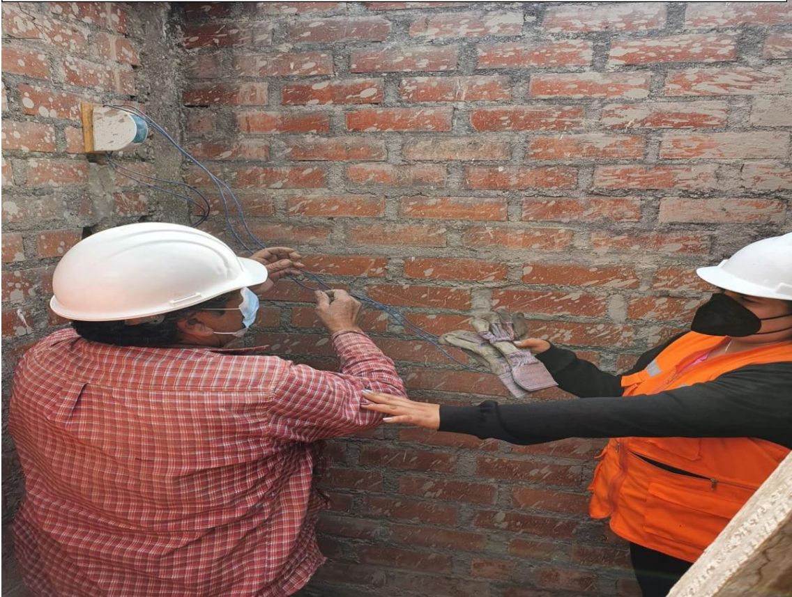
Aplicación de medidas correctivas
