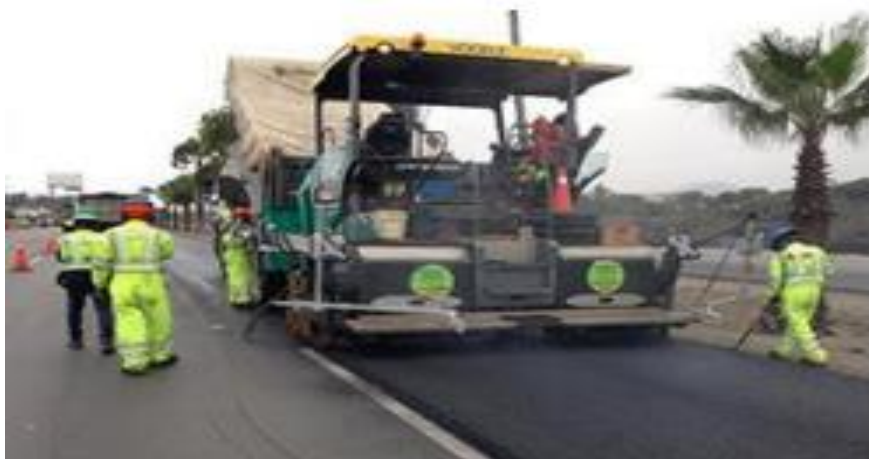
Figura 3. Mezcla asfáltica en caliente
