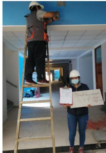
12. Realizando el ensayo de esclerómetro en V-1 (viga).
