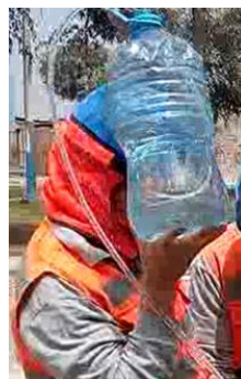
Figura 14. Botella con agua para evitar sobrecalentamiento del taladro de corte
