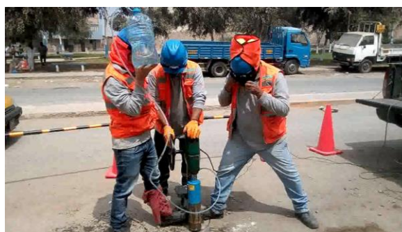
Figura 17. Foto completa de los operarios extrayendo una muestra de diamantina
