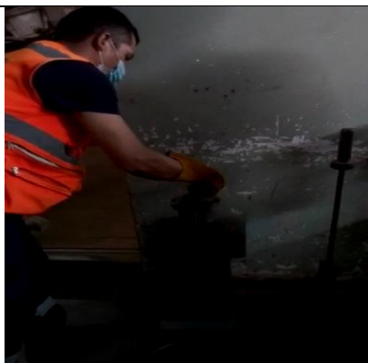
Figura. Técnico vertiendo la mezcla caliente para compactarlo Fuente: Elaboración personal
