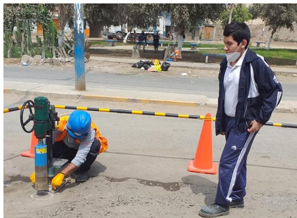
Figura 16. Otra foto del investigador viendo al operario preparar el taladro de corte
