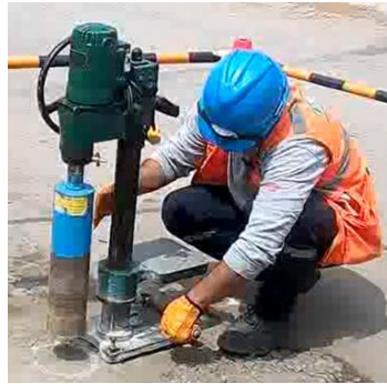
Figura 12. Operario preparando el taladro de corte
