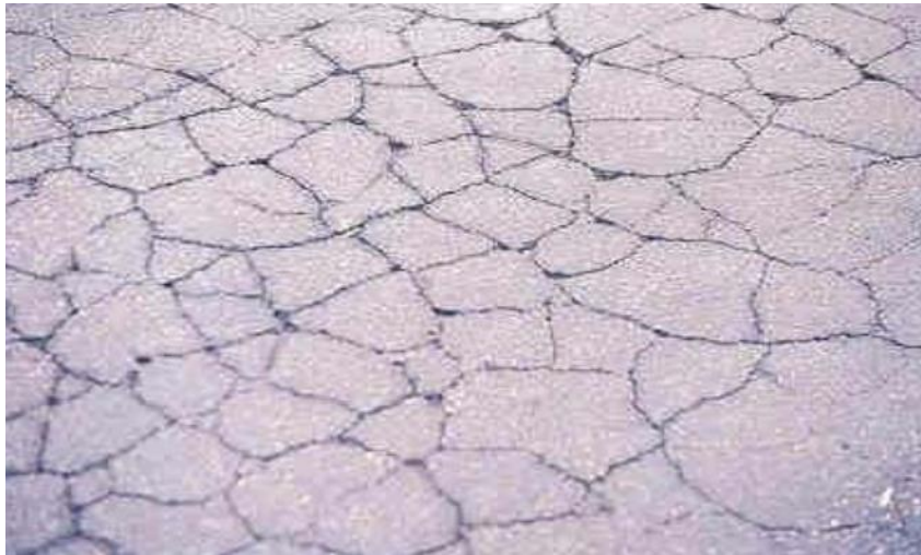
Figura 3. Daño por agrietamientos piel de cocodrilo
