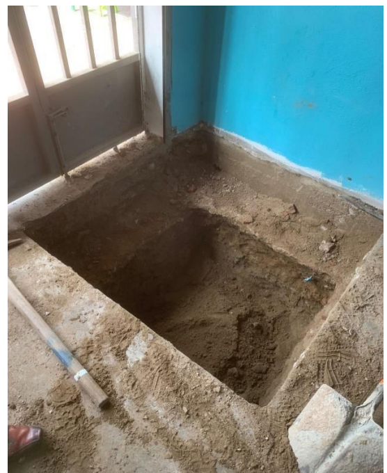
Figura 05: Calicata N°1 Fuente: Elaboración propia
