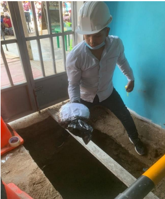
Figura 04: Calicata N°1 Fuente: Elaboración propia
