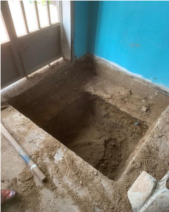
Figura 02: Calicata N°1 Fuente: Elaboración propia
