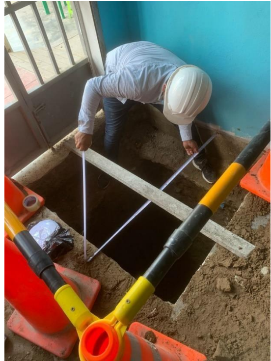
Figura 03: Calicata N°1 Fuente: Elaboración propia
