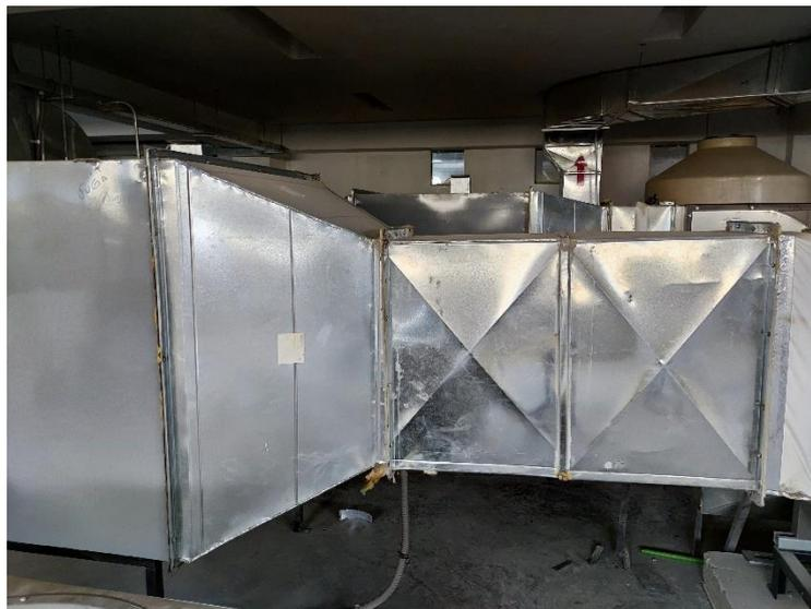
*Figura 21.* Unidades manejadoras de aire limpiadas – Piso Técnico
