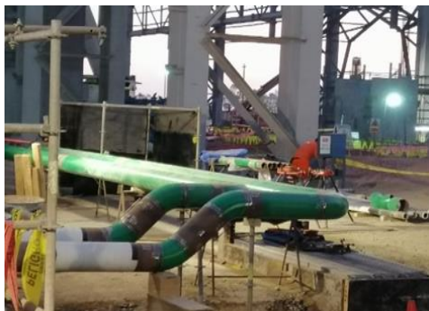
Figura 7. Soldadura de acero
