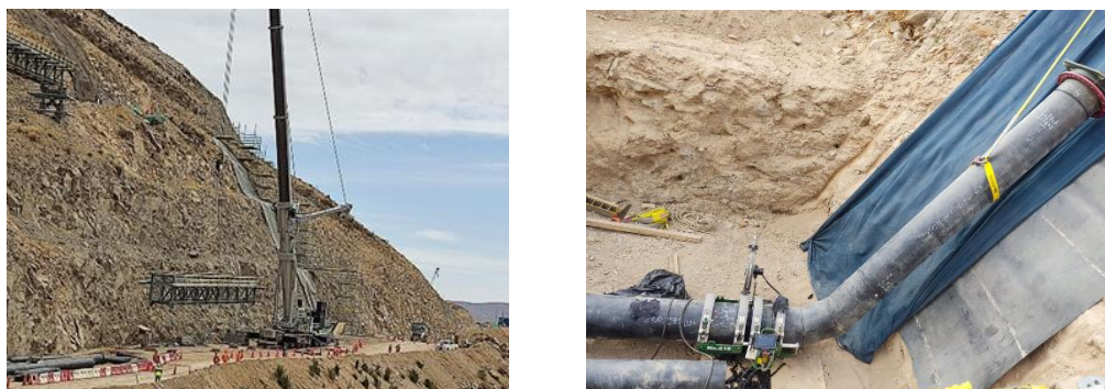
Figura 12. Trabajo de izaje
