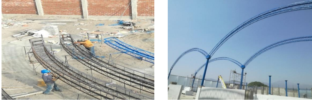
Figura 8. Armado de estructuras metálicas
