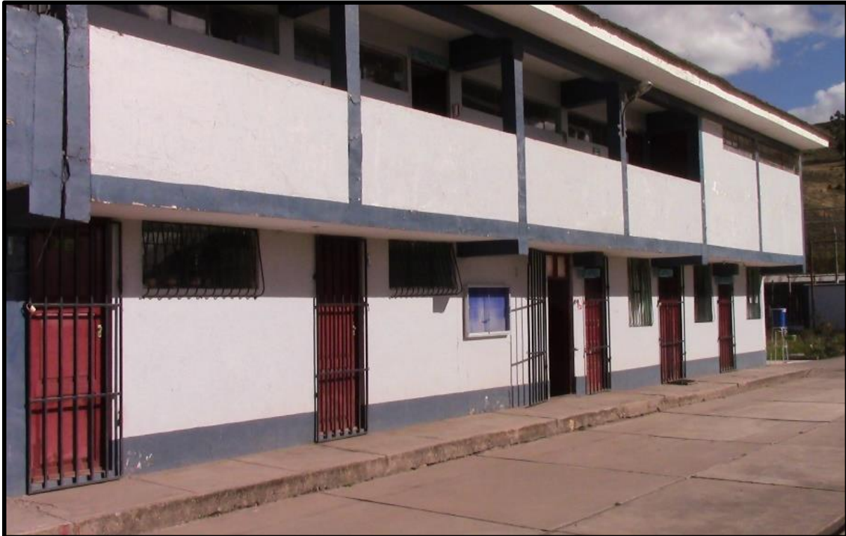
Figura 13. Recinto del Programa de estudios de Construcción Civil.
