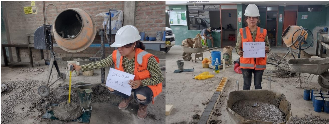
6. Preparación de la mezcla de concreto
